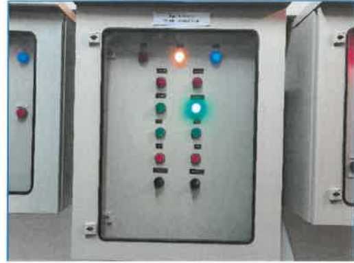
ตู้ควบคุมระบบเติมอากาศ
