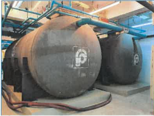
ระบบบำบัดน้ำเสียชนิดเติมอากาศ
