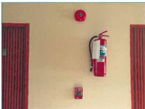
ถังดับเพลิงและระบบแจ้งเตือน
